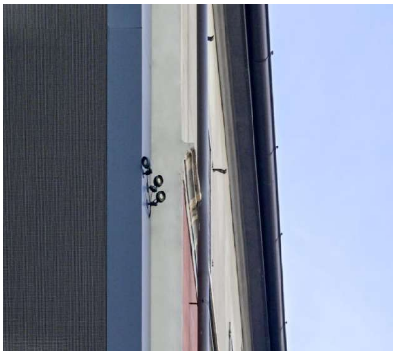
In foto un esempio di installazione dei sensori di Blimp
